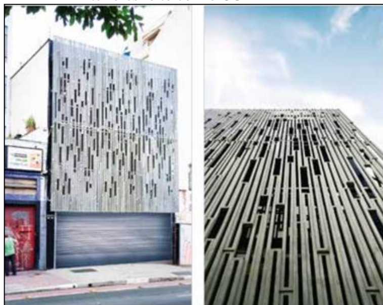
Figura 7 - Fachada do edifício do Ministério das Relações Exteriores feito com o CUAD
