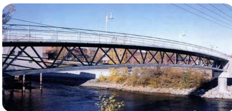
Figura 5 - Passarela para pedestre confeccionada com CUAD na cidade de Sherbrooke
